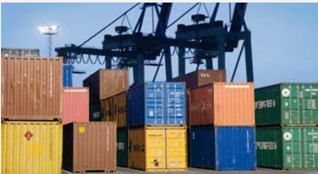
Lager auf dem HHLA Container Terminal Burchardkai.
