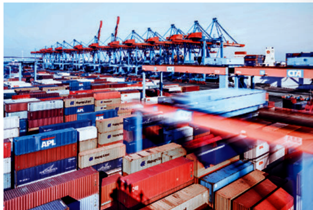
Dźwigi magazynowe obsługują magazyn blokowy CTA.
