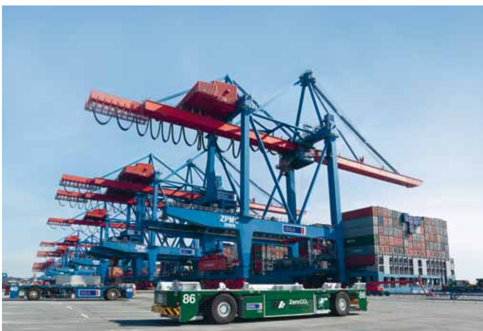
Automatisierte Containertransporter (AGV) mit Batterieantrieb auf dem HHLA Terminal in Hamburg-Altenwerder
