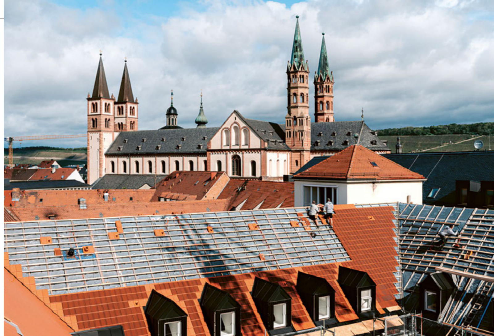
ÄHNLICHER ANSATZ: Denkmalgerechte Fotovoltaik auf dem Klosterdach der Kongregation der Erlörschwwestern in Würzburg. Mithilfe der Spezialisten für energiebewusstes Bauen des Bayerischen Landesamtes für Denkmalpflege (BLfD) wird das gesamte Klosterareal saniert.
