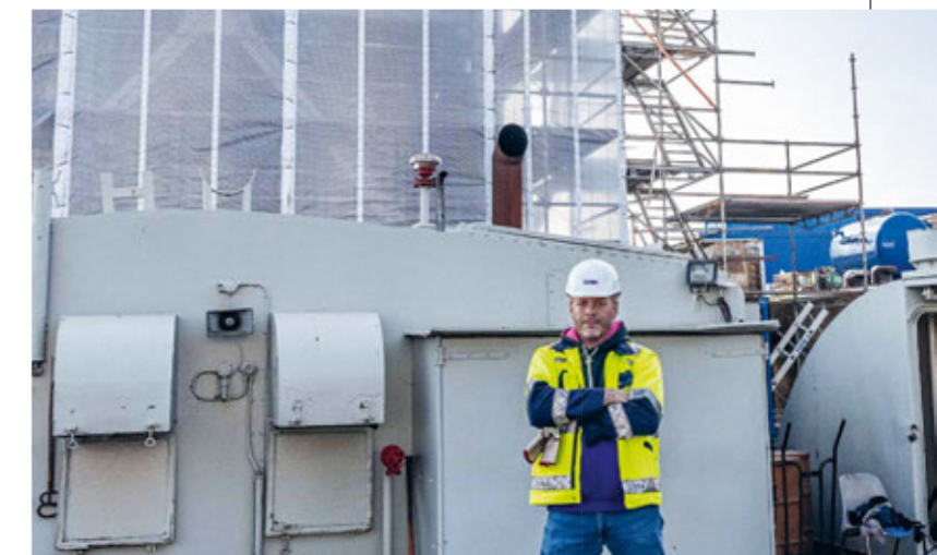
STEPHAN FRÖHLICH , Leiter der HHLA Schwimmkräne, vor dem eingerüsteten Oldie.
