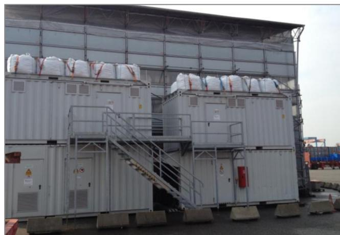
Abbildung 43: Aufstellcontainer außerhalb der Leichtbauhalle (beschwert);
