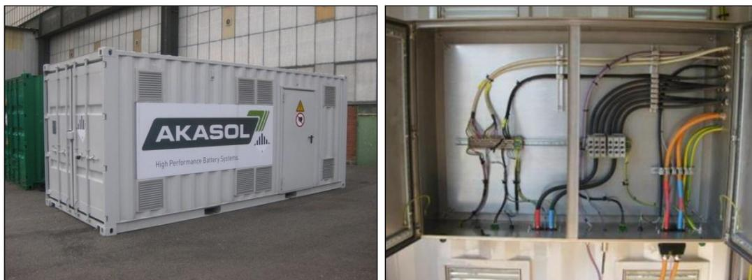
**Abbildung 91:** Aufstellcontainer mit Ladegeräteeinheit für Lithium-Batteriesysteme am Werkstandort in Düsseldorf und Verteilerschrank mit Steckvorrichtung Automatikbetrieb/Handladebetrieb
