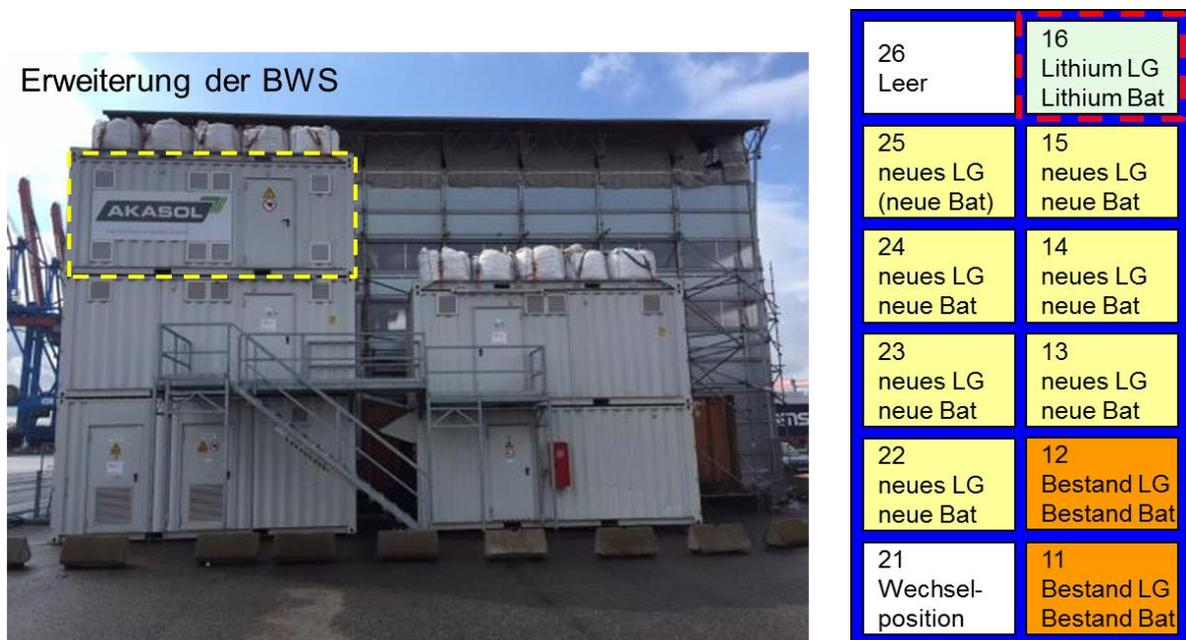
Abbildung 97: Erweiterung der Batteriewechselstation (BWS) um eine Ladegeräteinheit für die Lithium-Batteriesysteme
